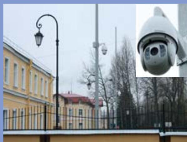
*Наблюдение осуществляется с помощью скоростных купольных поворотных уличных IP камер высокого разрешения*
